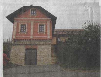
Glaviničevi že oddajajo apartma v svoji obnovljeni, 110 let stari vinski kleti. Foto Jože Pojbič
